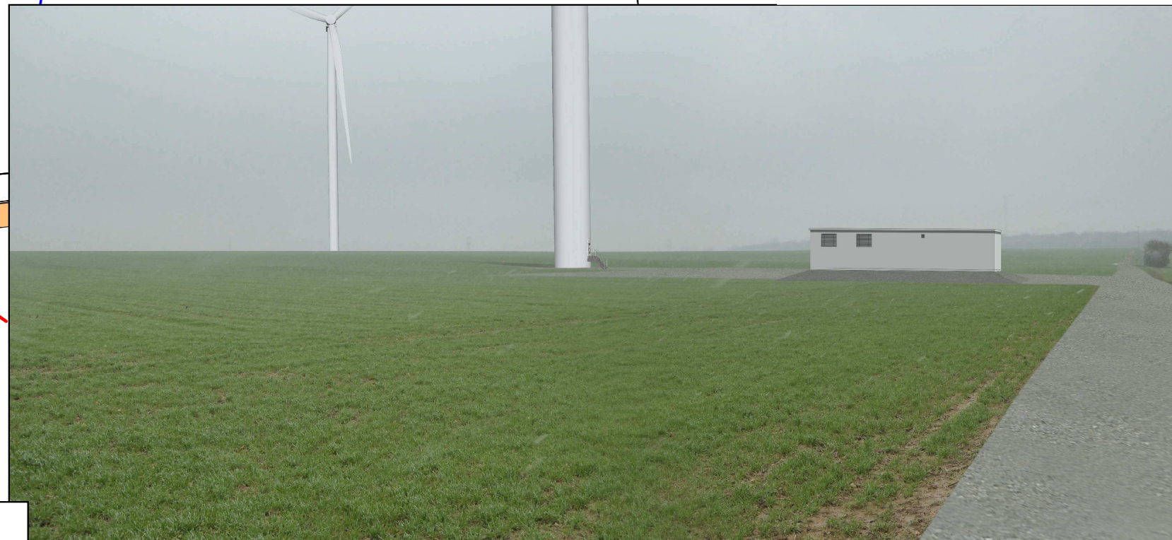
Après l'implantation du poste de livraison
