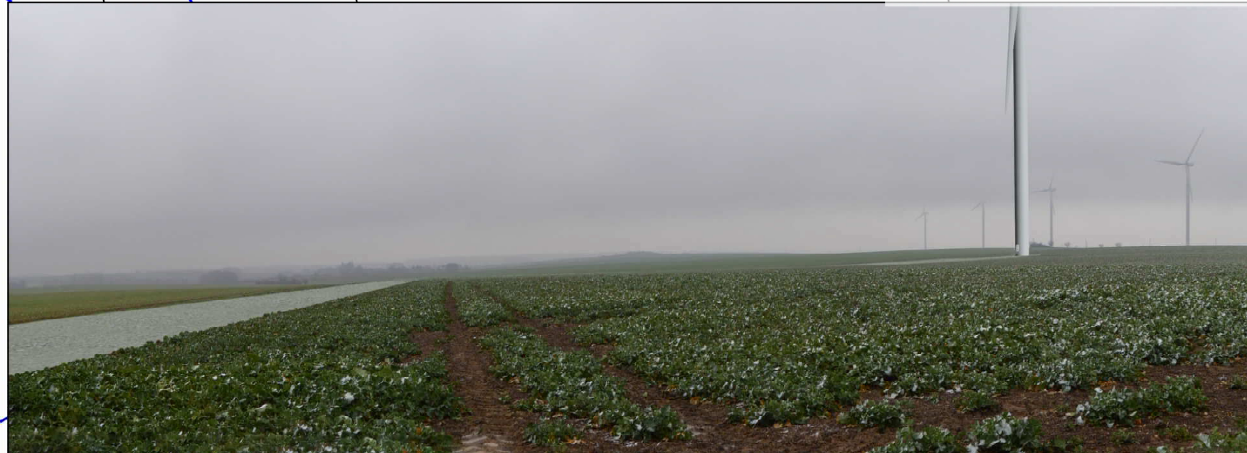
Après l'implantation de l'éolienne
